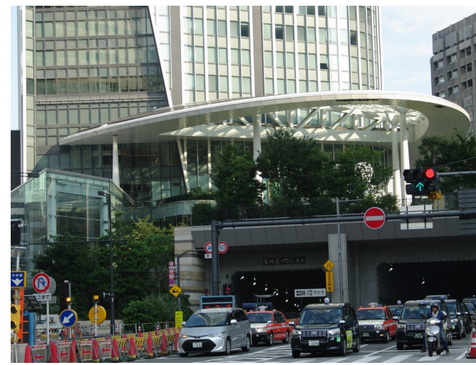
地下を貸付けた東京都が設けた幹線 道路の上に立つ超高層の虎ノ門ヒルズ
