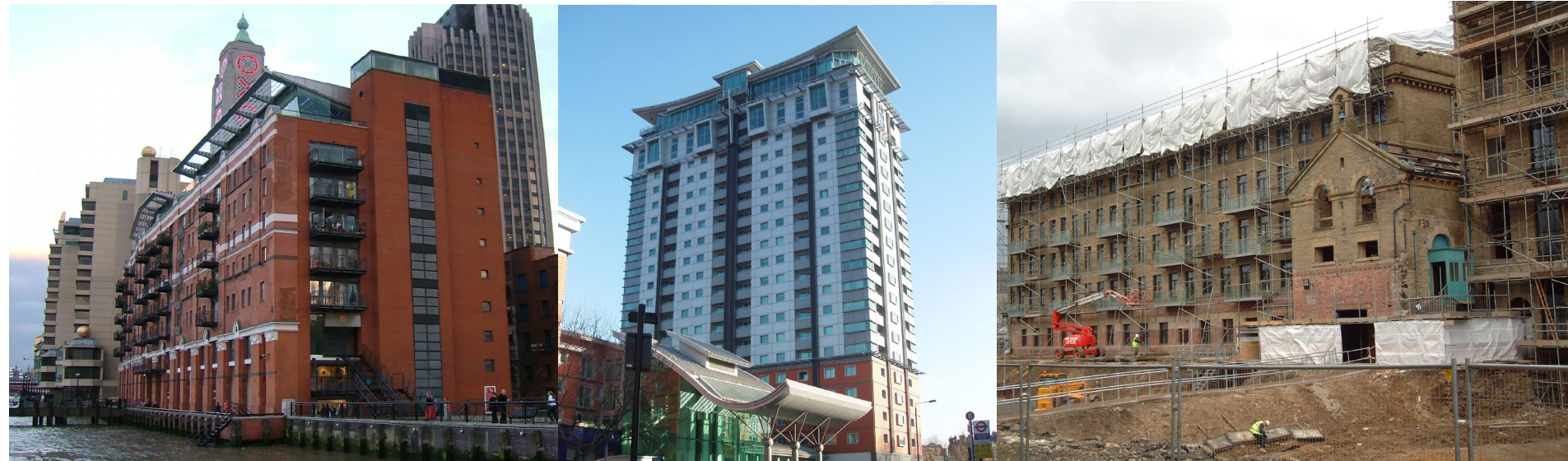
倉庫からマンションとレストランに転用し1階に遊歩道を貫通させて再生
